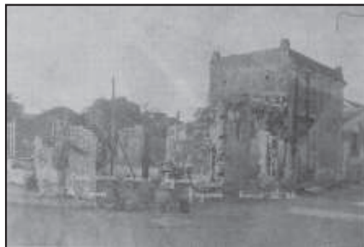
Ruinas de la casa donde nació Francisco Vicente Aguilera
