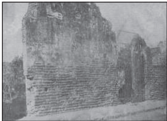
Ruinas de la casa donde nació Juan Clemente Zenea
